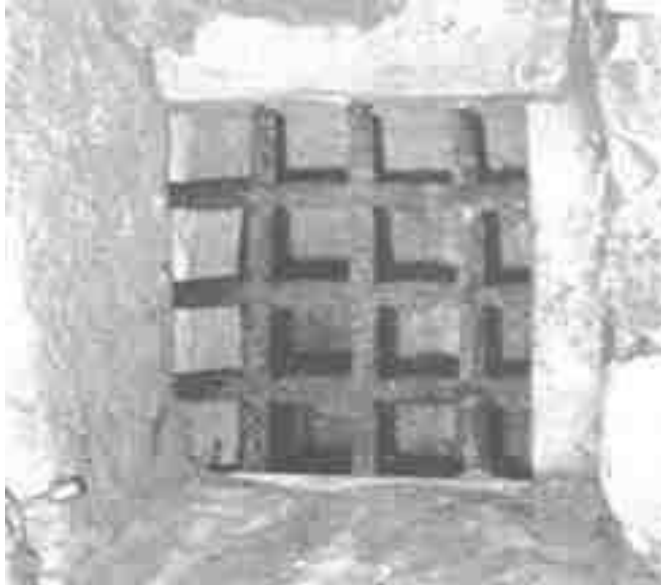
Pl. 13 Fenêtre Grillagée Salle Souterraine du XIIe
